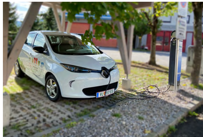
| schattige Ladestation - kühles Auto - kühles Gemüt!
